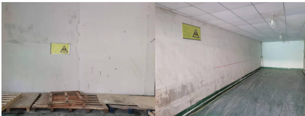
图 5.1-2 危废仓库（地面环氧地坪、防渗托盘）
